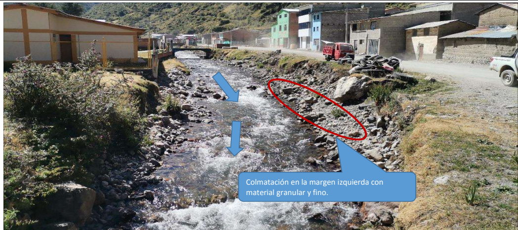
FIGURA N°01: QUEBRADA VICHAYCOCHA COLMATADO EN EL SECTOR CHICAYCOCHA, CON LA PRESENCIA DE MATERIAL GRANULAR; LAS CUALES DEBEN SER DESPLAZADOS HACIA AMBOS MARGENES PARA QUE EL CAUCE MANTENGA SU SECCIÓN HIDRÁULICA TÍPICA.
